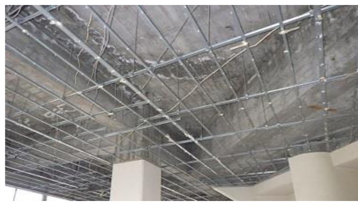
2階ロビー天井剥がし作業
