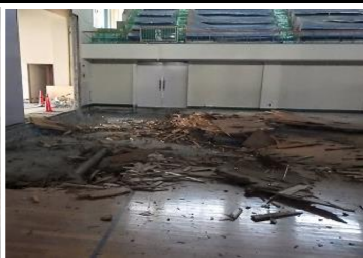
メインアリーナの床剥がし作業
