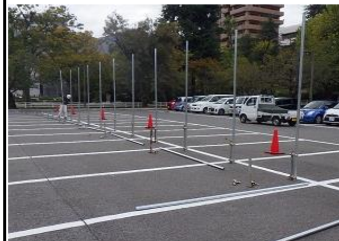
資材置場・工事車両用仮囲設置作業
