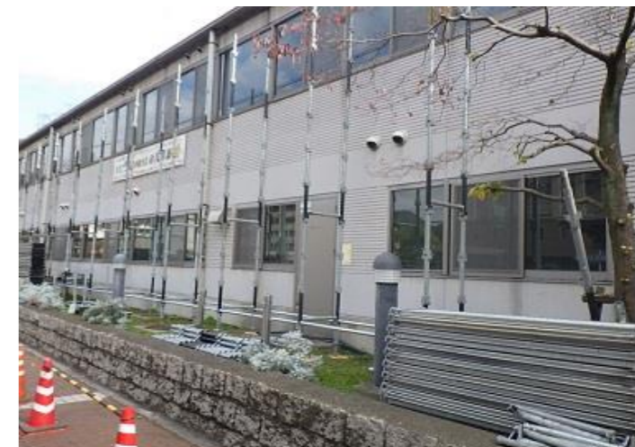
会議室棟の足場設置作業
