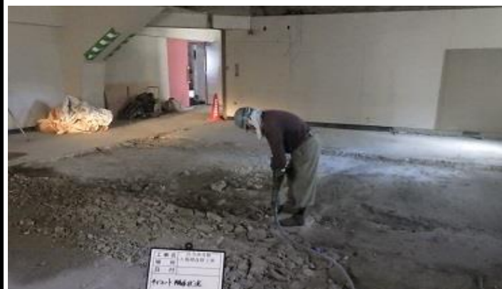
1階西側トイレ床はつり作業
