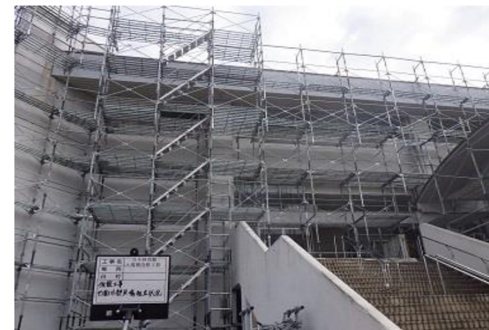
北西側 裁判所前の足場組み立て作業
