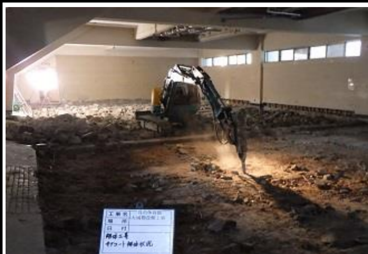
サブコートのコンクリートはつり作業
