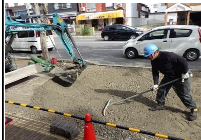
工事車両出入り口の舗装作業
