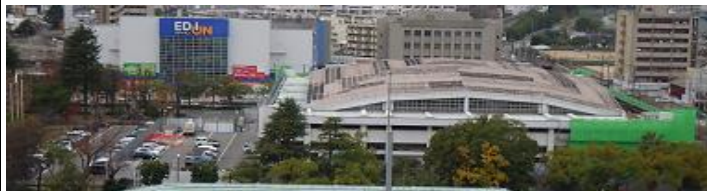
呉市役所から見た仮囲い・足場の取り付けの様子
