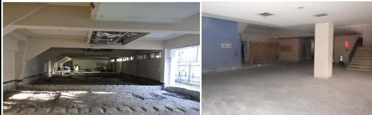
サブコートの壁撤去の様子(耐震補強のため)
