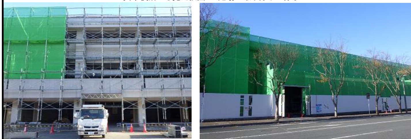
駐車場側足場設置の様子
