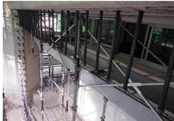
耐震工事のための鉄筋埋め込み
