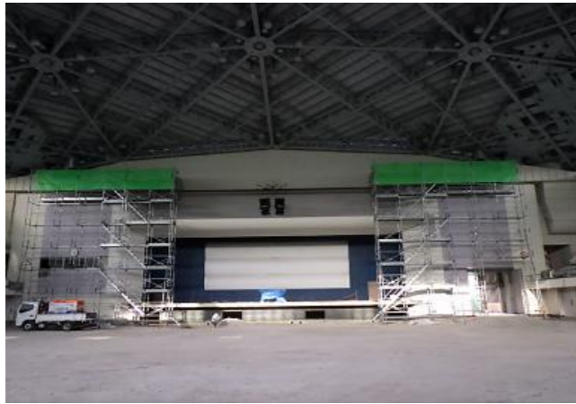
屋根部分の工事のための足場設置
