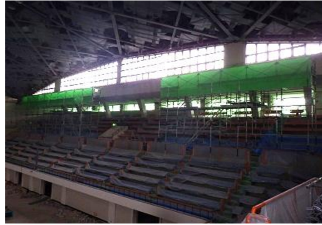
屋根部分の工事のための足場設置
