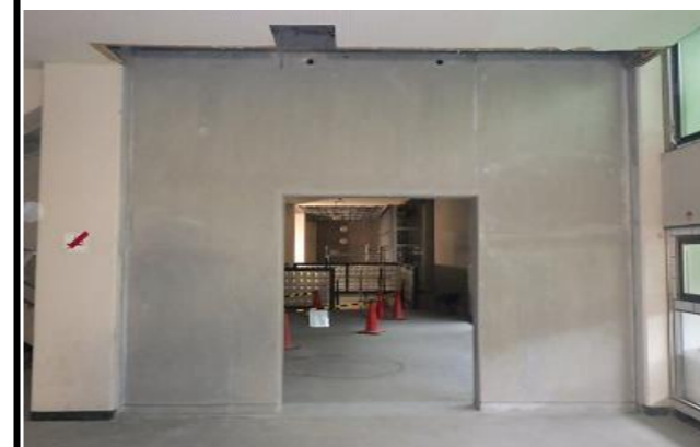
2階ロビー耐震補強
