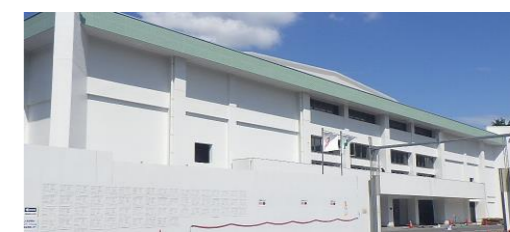
南側(海側)外観
